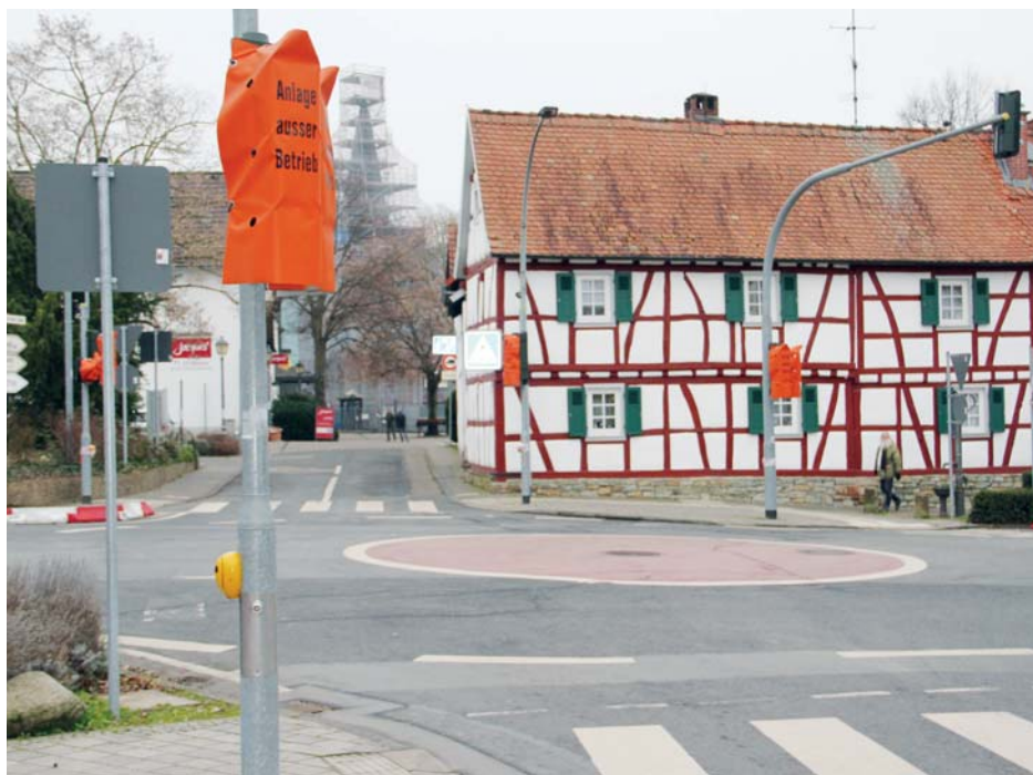
Obwohl der Kreisverkehr am „Großen Dalles“ längst etabliert ist, stehen die Ampeln immer noch da. Die Gemeinde kann diese aber nicht abbauen, da sie dem Main-Taunus-Kreis gehören. Bei der Sanierung der Straße sollen sie demontiert werden. Foto: Schöffel
