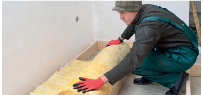
Eine Dämmung aus Mineralwolle senkt den Energieverbrauch und die damit verbundenen Kosten eines Gebäudes bei gleichzeitig verbessertem Schall- und Brandschutz. Einfache Maßnahmen können in Eigenregie durchgeführt werden. Foto: DJD/Smole-stock.adobe.com
