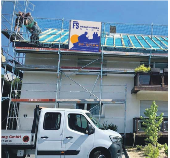
Gerade bei Bestandsgebäuden lohnen sich neue Dächer mit einer hocheffizienten Dämmung. Wichtig ist, dass Spezialisten von zertifizierten Betrieben die Arbeiten ausführen. Foto: FS Bedachungen
