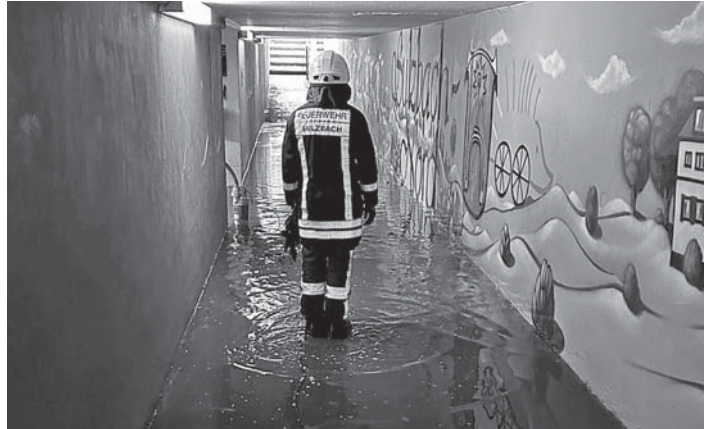
Wasser im Tunnel. Durch Regenfälle überflutet war am Donnerstagnachmittag vergangener Woche die Unterführung an der S-Bahn-Station Sulzbach-Nord. Ein trockenes Durchqueren des Tunnels zwischen der Staufenstraße und der Verlängerung der Neugartenstraße war nicht mehr möglich. Die Feuerwehr pumpte das Wasser mit einer Tauchpumpe ab. Anschließend wurden die Abflüsse gereinigt, so dass der Durchgang wieder passierbar war. Foto: Feuerwehr
