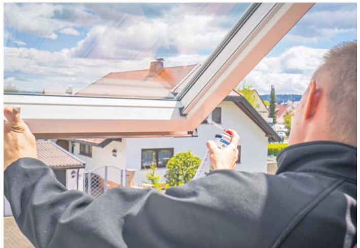
Ofť fehlt nur ein Tropfen Öl an der richtigen Stelle, manchmal muss eine Dichtung oder ein Teil des Beschlags ausgetauscht werden, damit ein Dachfenster wieder einwandfrei funktioniert. djd/Foto: TLS-Dachfenster
